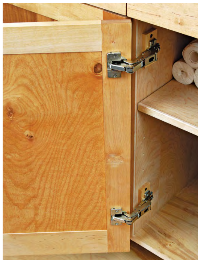
Im Inneren versteckt. Bei Möbeln ohne Blendrahmen wird die Tür von den Seiten- und Trennwänden getragen. Die Topfscharniere im Foto erfordern am Korpus angeleimte Holzklötze, um die Tür richtig auszurichten.
