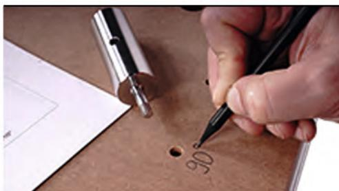
Ein mitgeliefertes Schema hilft Ihnen, die neue Arbeitsplatte mit den korrekten Winkelangaben zu beschriften.
